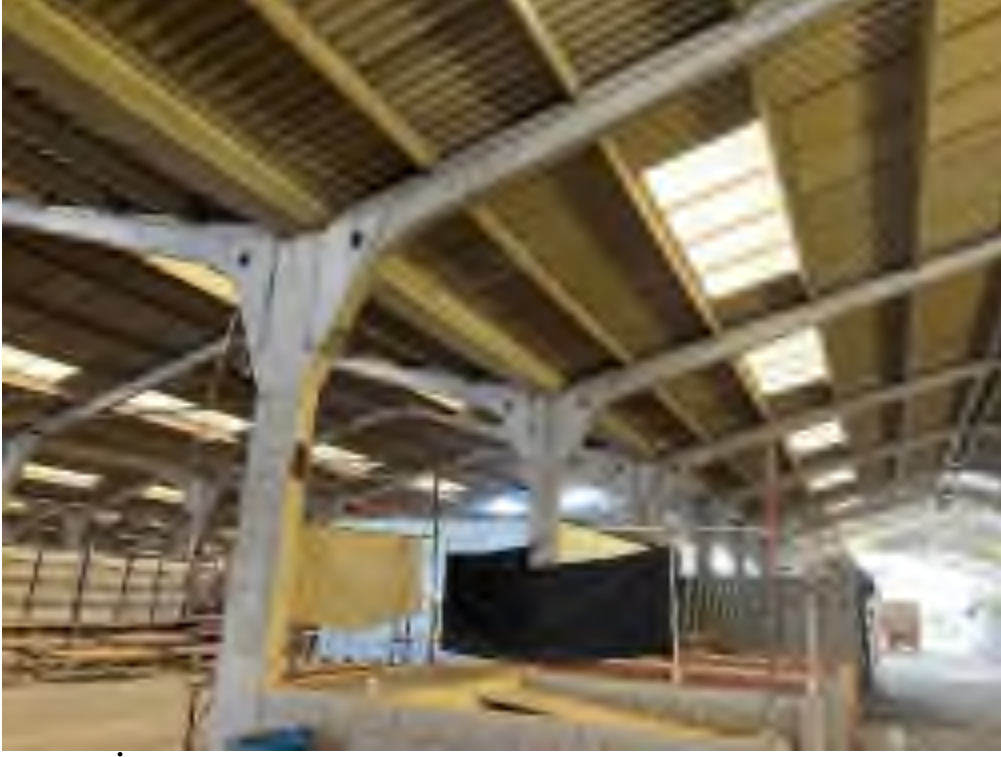
Çatının İçten Görünümü
